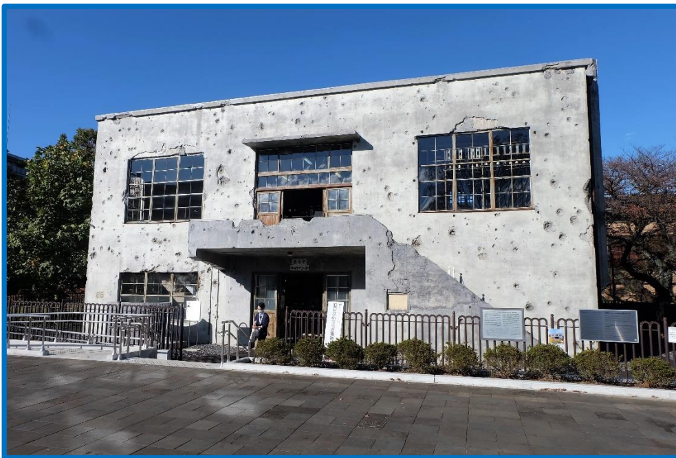
2度目の修復工事を終え、公開が始まった旧日立航空機立川工場変電所（2021年10月撮影）
