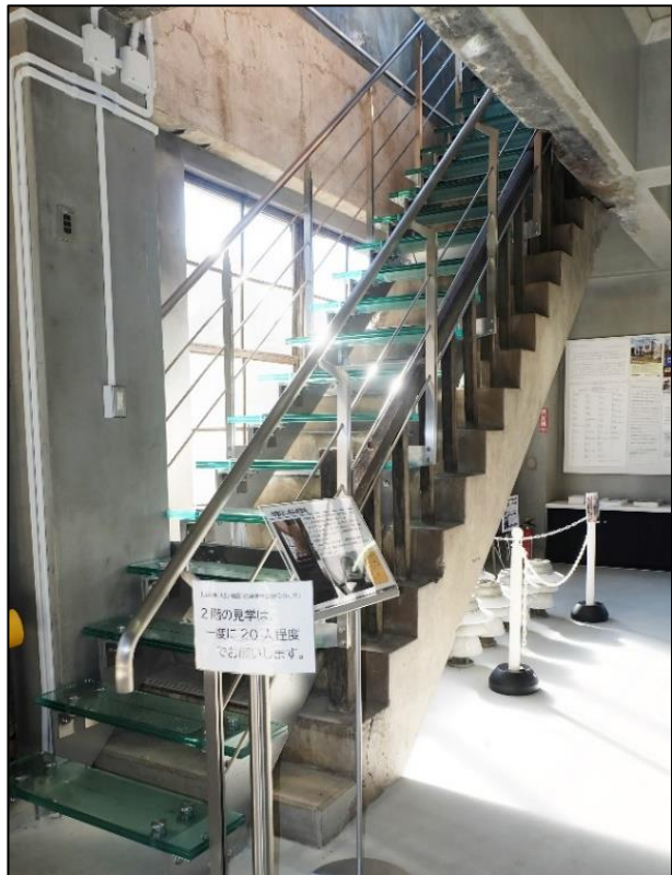
内階段にガラス製の階段を設け、機銃掃射の痕跡の残る元の階段の保護と観察を可能とした。
