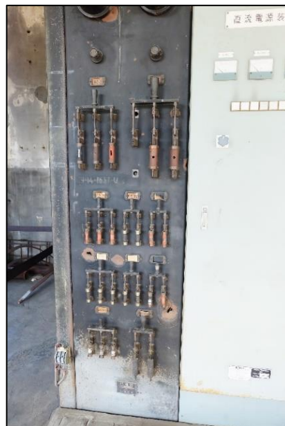
(上) 右側に見える配電盤のうち一番奥の低圧配電盤のみ建設当初設置のもの 高圧配電盤は戦後入れ替え
