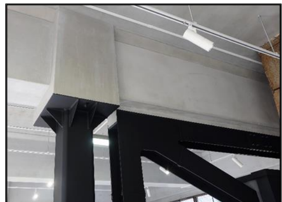
(右下) 鉄柱上部の梁も1995年の工事でもとからあったものを補強した。
